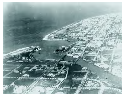
Conexiones entre El Vedado y Miramar, 1926. Fototeca Ministerio de la Construcción, procesada por Juan de las Cuevas Toraya.
